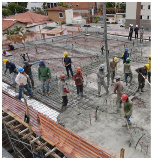
Imagem da concretagem da laje de transição do Magnifique Tower
